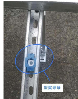
图2.12 塑翼螺母的使用
