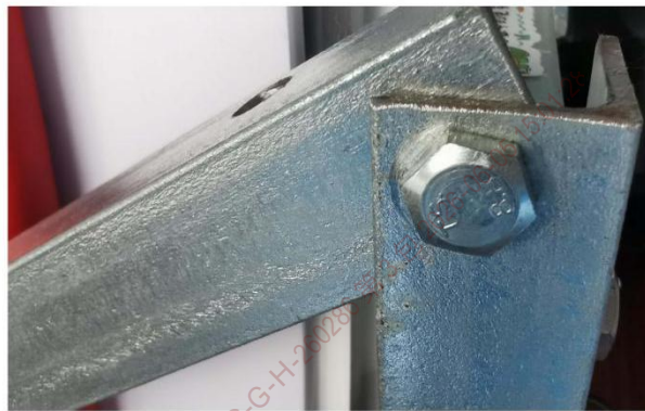
图2.14 外六角螺栓固定局部
