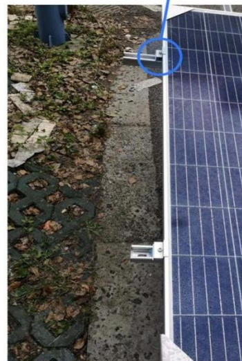
图3.2 使用压块的固定图
