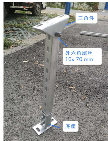
图2.10 立柱、三角件和底座组装实物图
