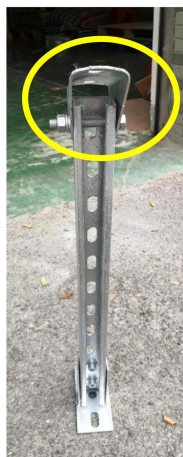
图2.9 立柱与三角件的连接
