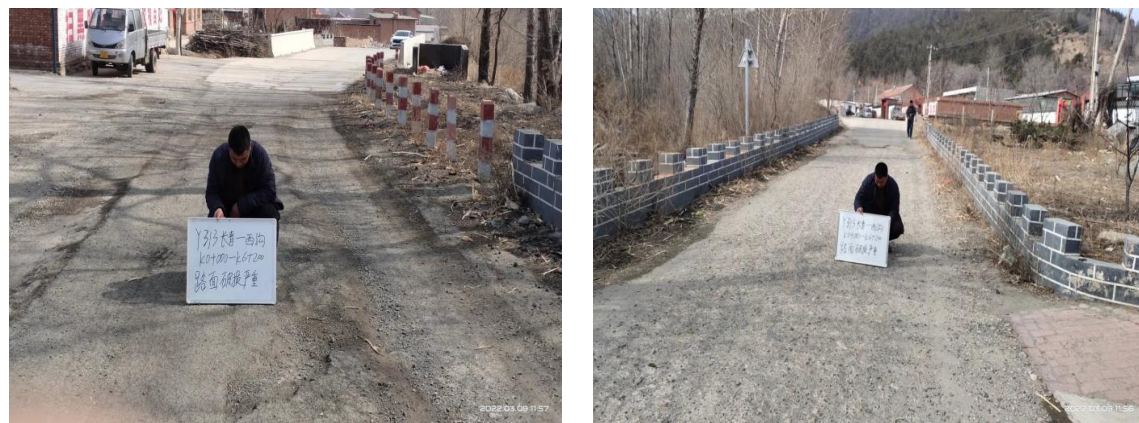
(5) 示警桩表面颜色褪色，示警作用不明显。
