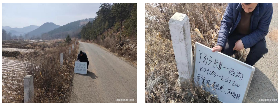
(5) 示警桩表面颜色褪色，示警作用不明显。
