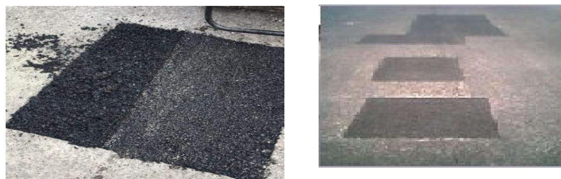
图 2.3 修补坑槽
