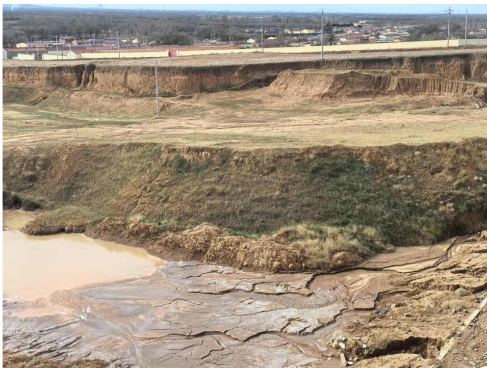
照片 边坡 BP3 现场照片
