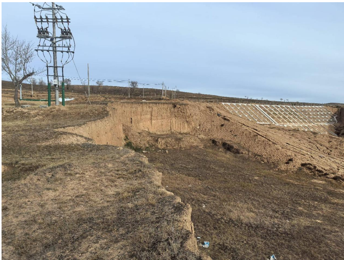
照片 采坑现场照片 2
