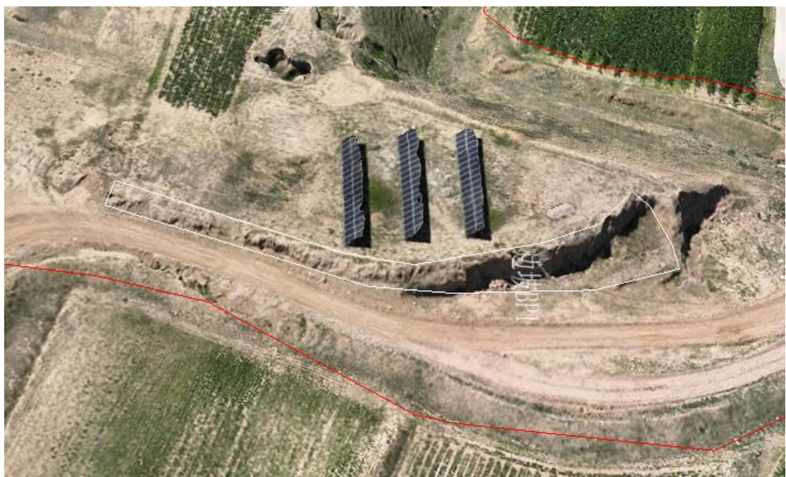
照片 边坡 BP1 三维影像
