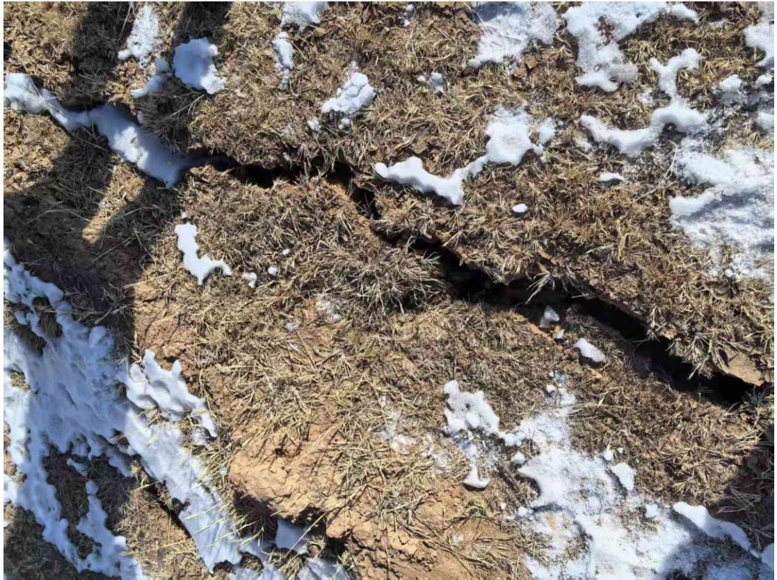
照片 边坡 BP3 坡顶边缘现场照片
