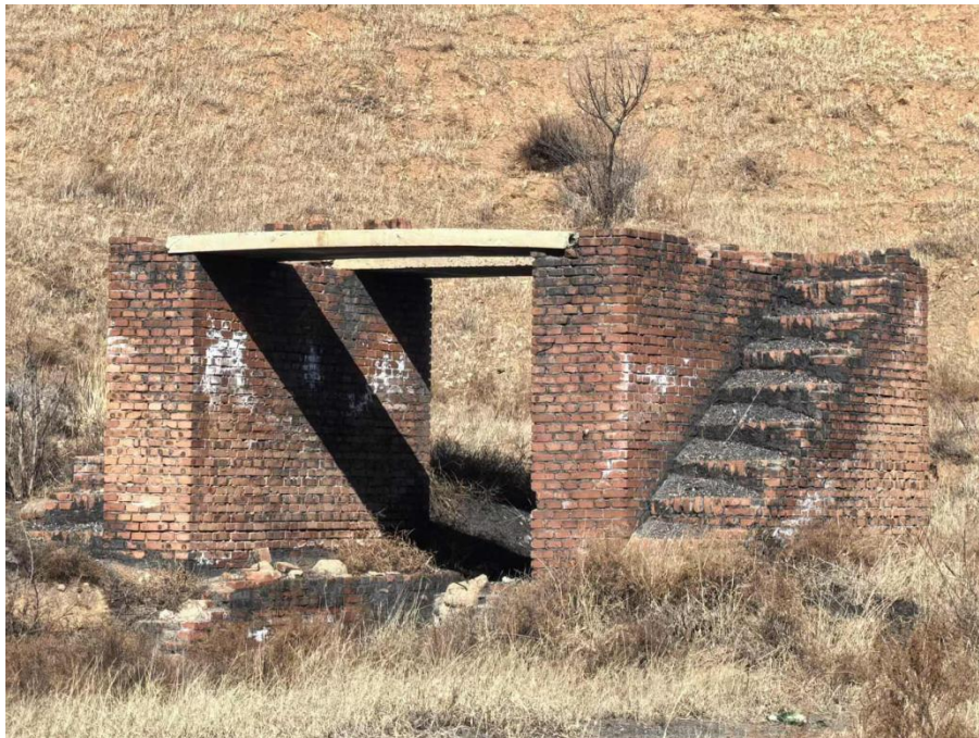
废建筑 FJZ4 现场照片
