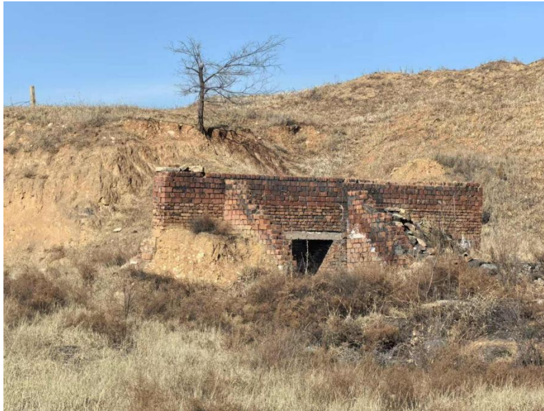
废建筑 FJZ1 现场照片
