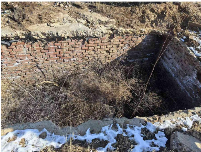
废建筑 FJZ2 现场照片
