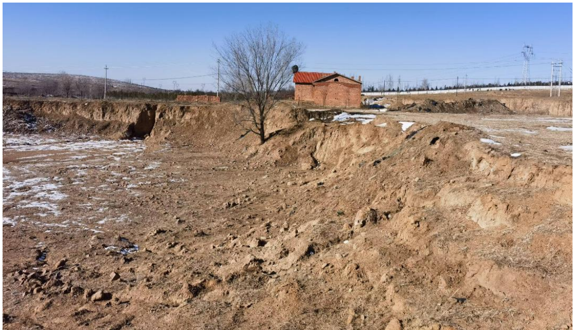
照片 边坡 BP1 现场照片
