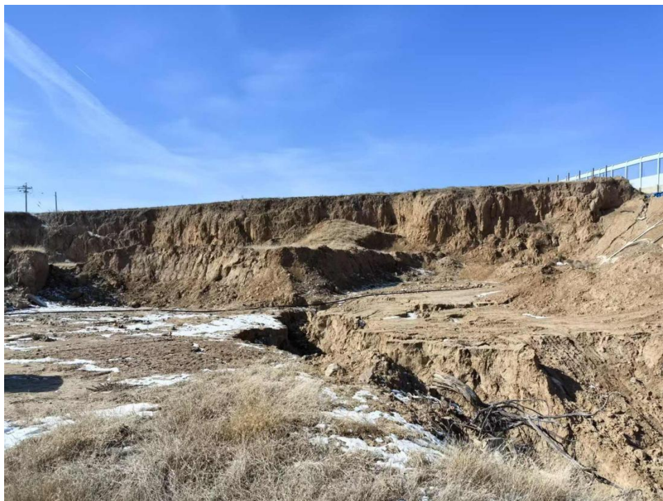
照片 边坡 BP1 现场照片
