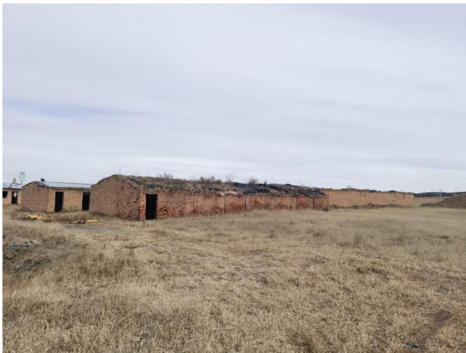
照片 废弃建筑 FJ7 现场照片
