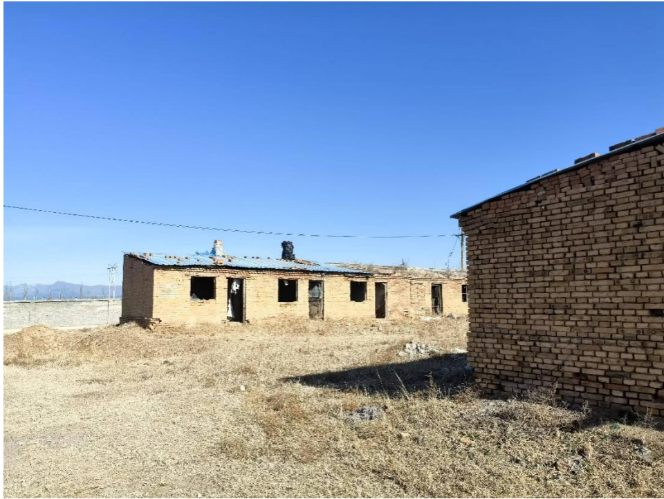
照片 废弃建筑 FJ3 现场照片
