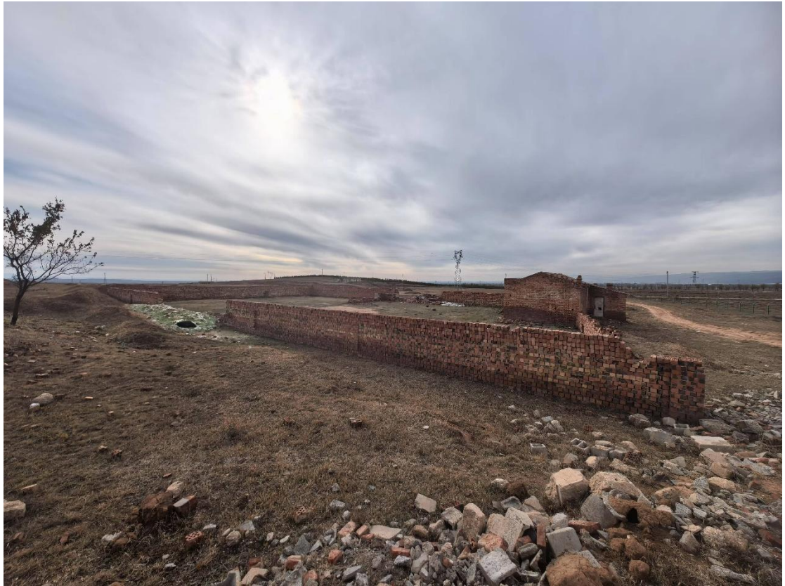
照片 废弃建筑 FJ2 现场照片
