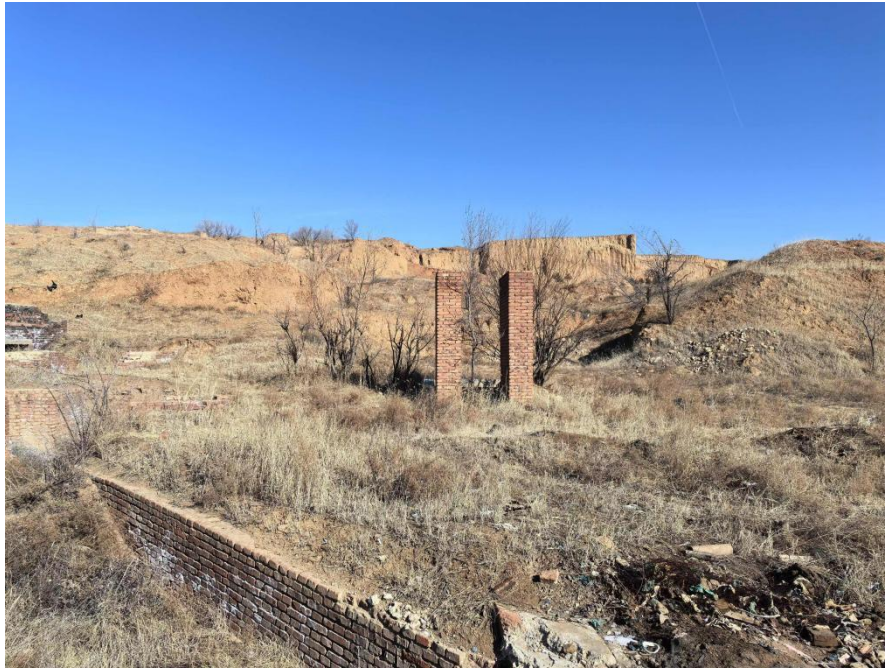
废建筑 FJZ3 现场照片
