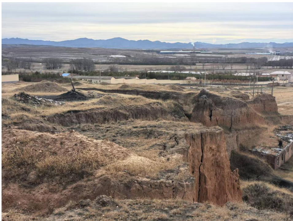
照片 边坡 BP2 现场照片
