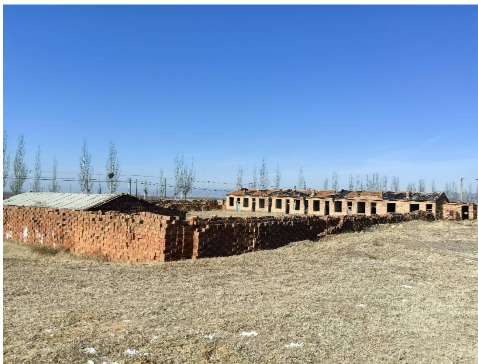
照片 废弃建筑 FJ1 和 FJ2 现场照片
