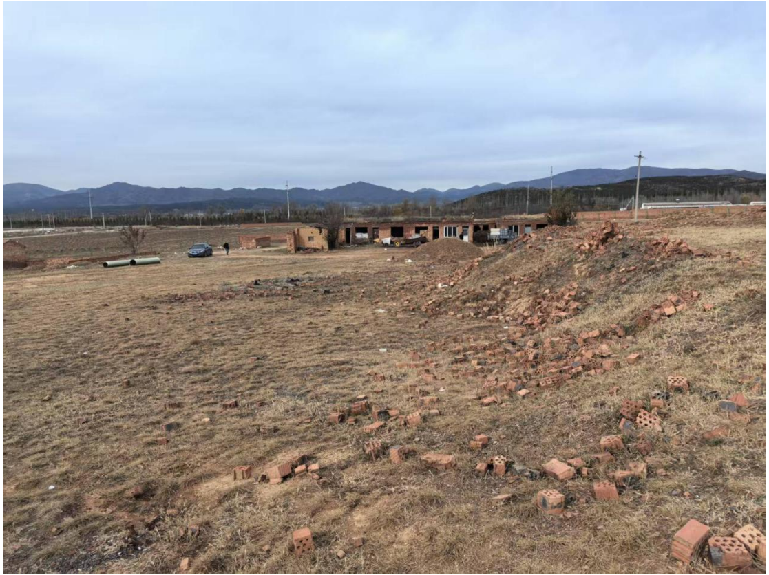
照片 边坡 FZ2 现场照片
