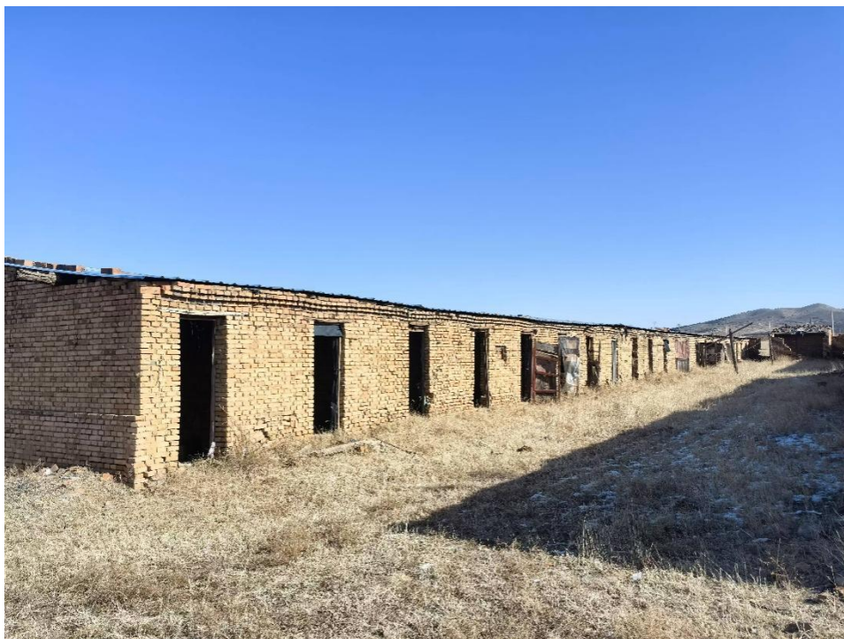
照片 废弃建筑 FJ5 现场照片
