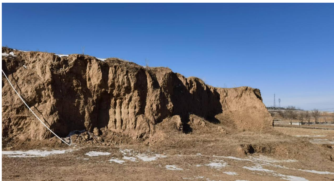
照片 边坡 BP1 现场照片
