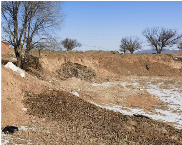
照片 边坡 BP2 现场照片
