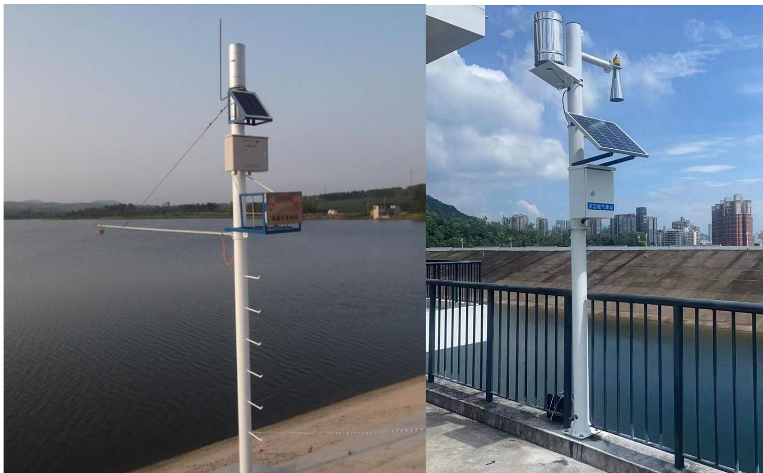
图 3.7.3- 2 雨量水位一体站安装效果示意图
