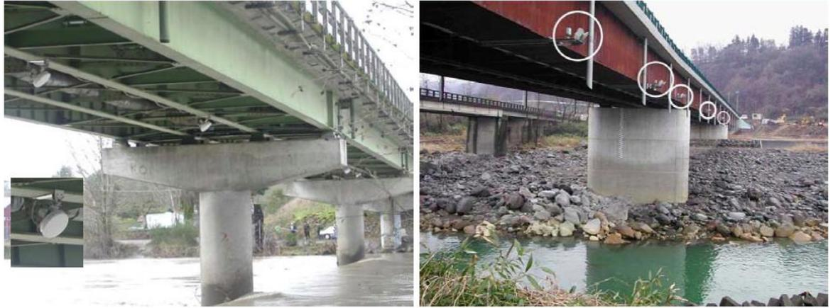
图 3 非接触式水位流量测量设备安装现场
