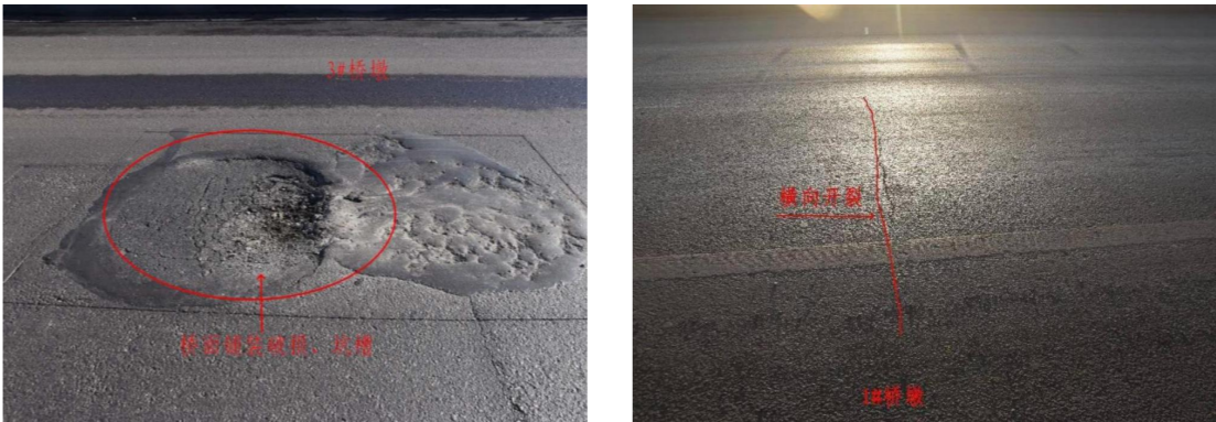
图 2.3.6 桥梁桥面损坏
