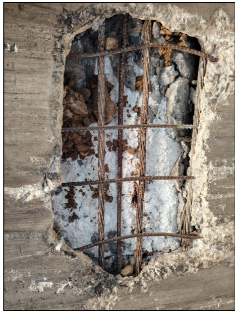
混凝土破损露筋示意
