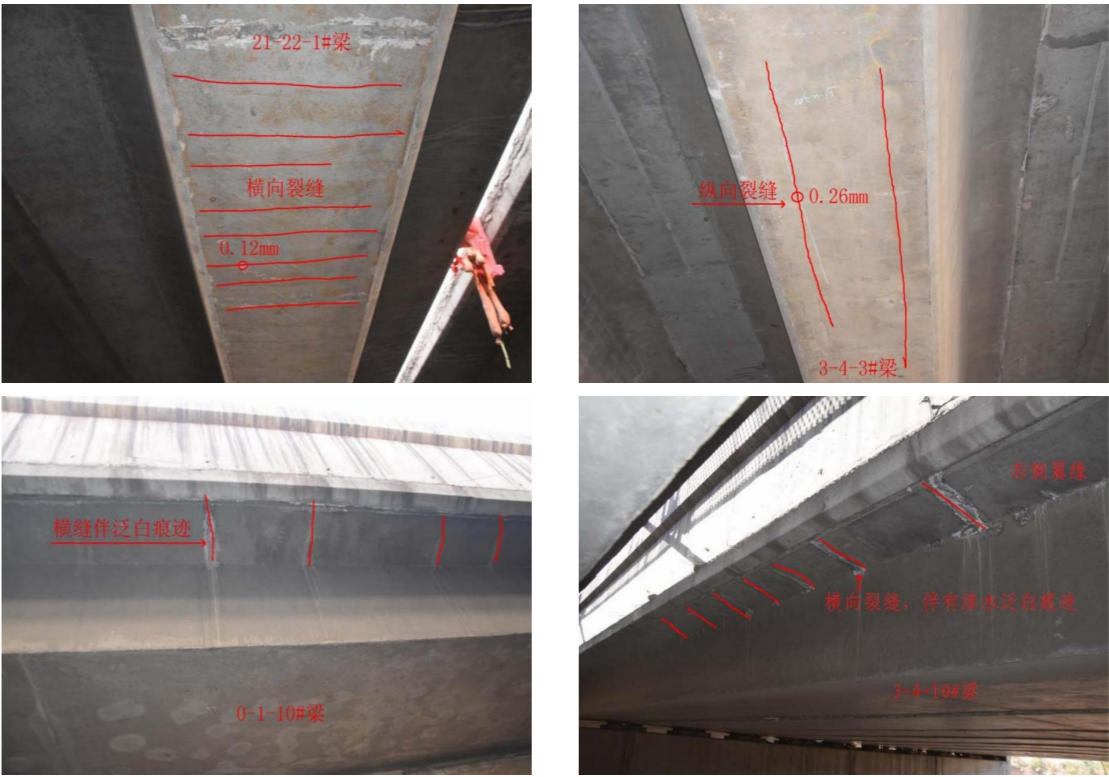
图 2.3.1 桥梁、板裂缝
