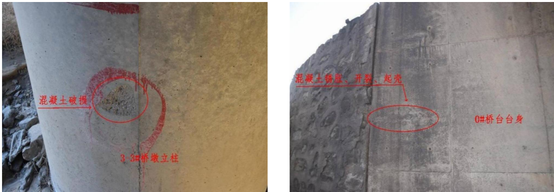
图 2.3.2 混凝土破损
