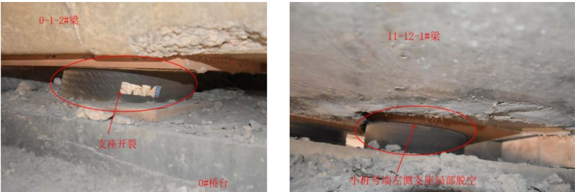
图 2.3.5 支座开裂、脱空
