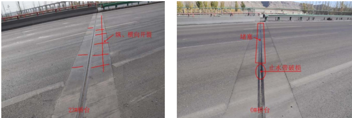
图 2.3.3 桥梁伸缩缝损坏
